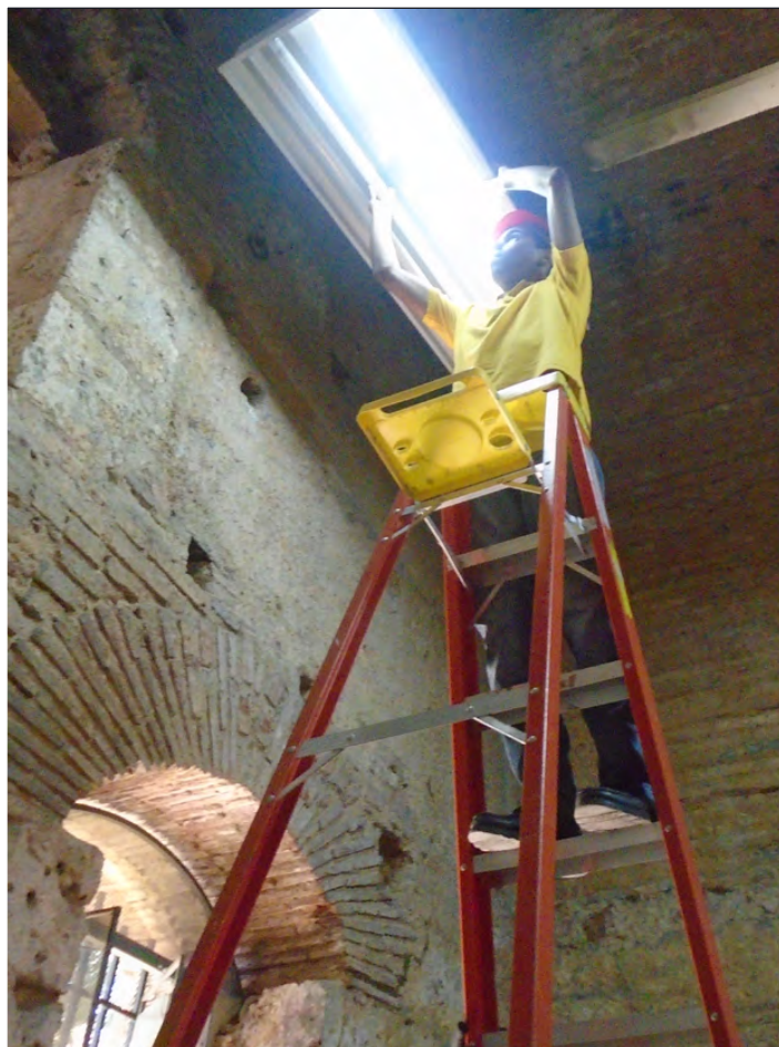
Intervención. Mantenimiento correctivo lámparas fluorescentes y bajo consumo.
