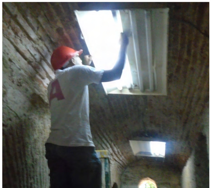
Intervención. Mantenimiento correctivo lámparas fluorescentes y bajo consumo.
